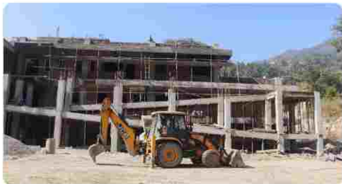
निर्माणाधीन शिजपुरी आधारभूत अस्पताल भवनको
