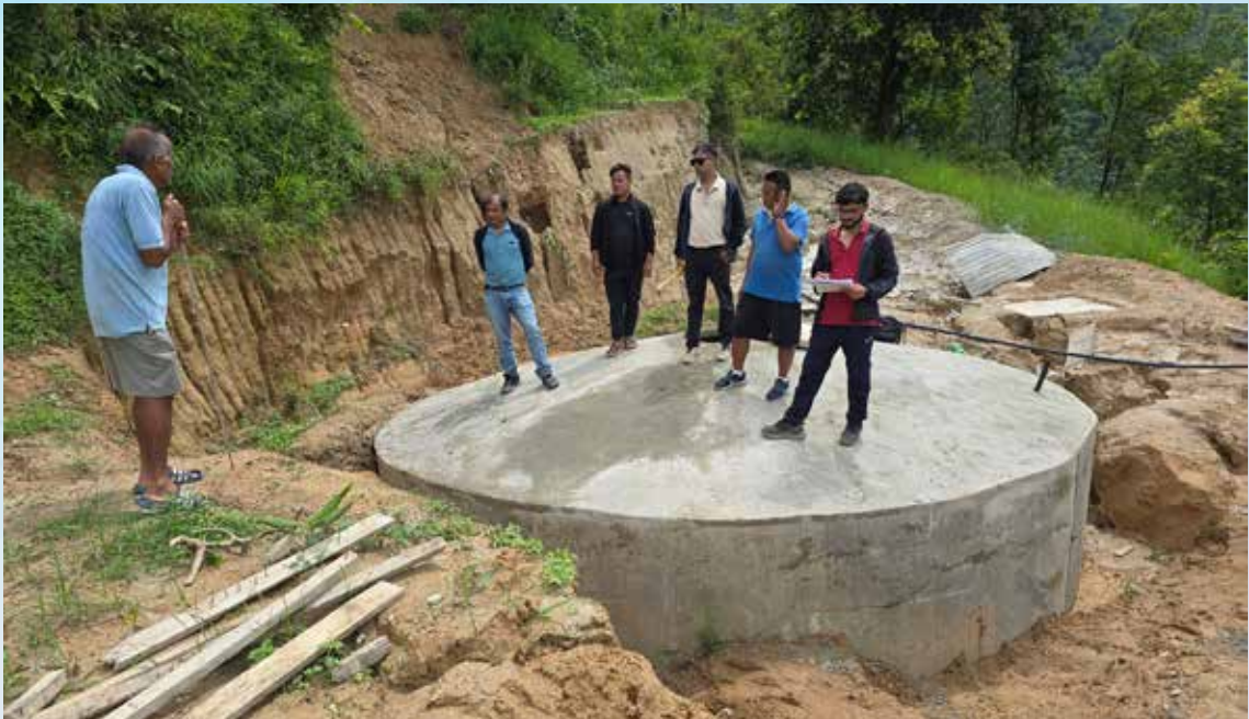
वडा नं. ८ खानेपानी ट्याङ्की निर्माण
