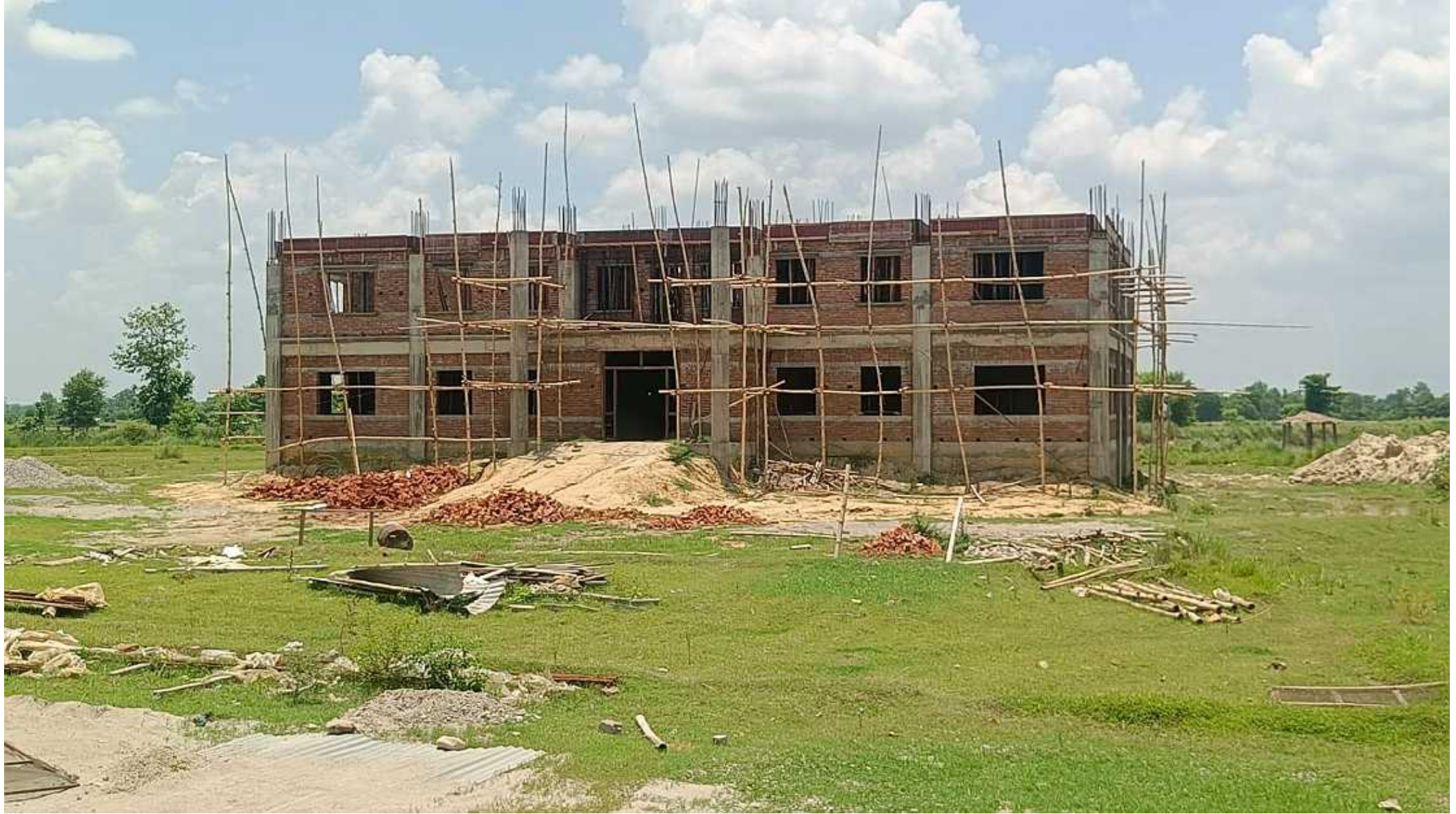
निर्माणाधिन गाउँपालिका प्रशासकीय भवन
