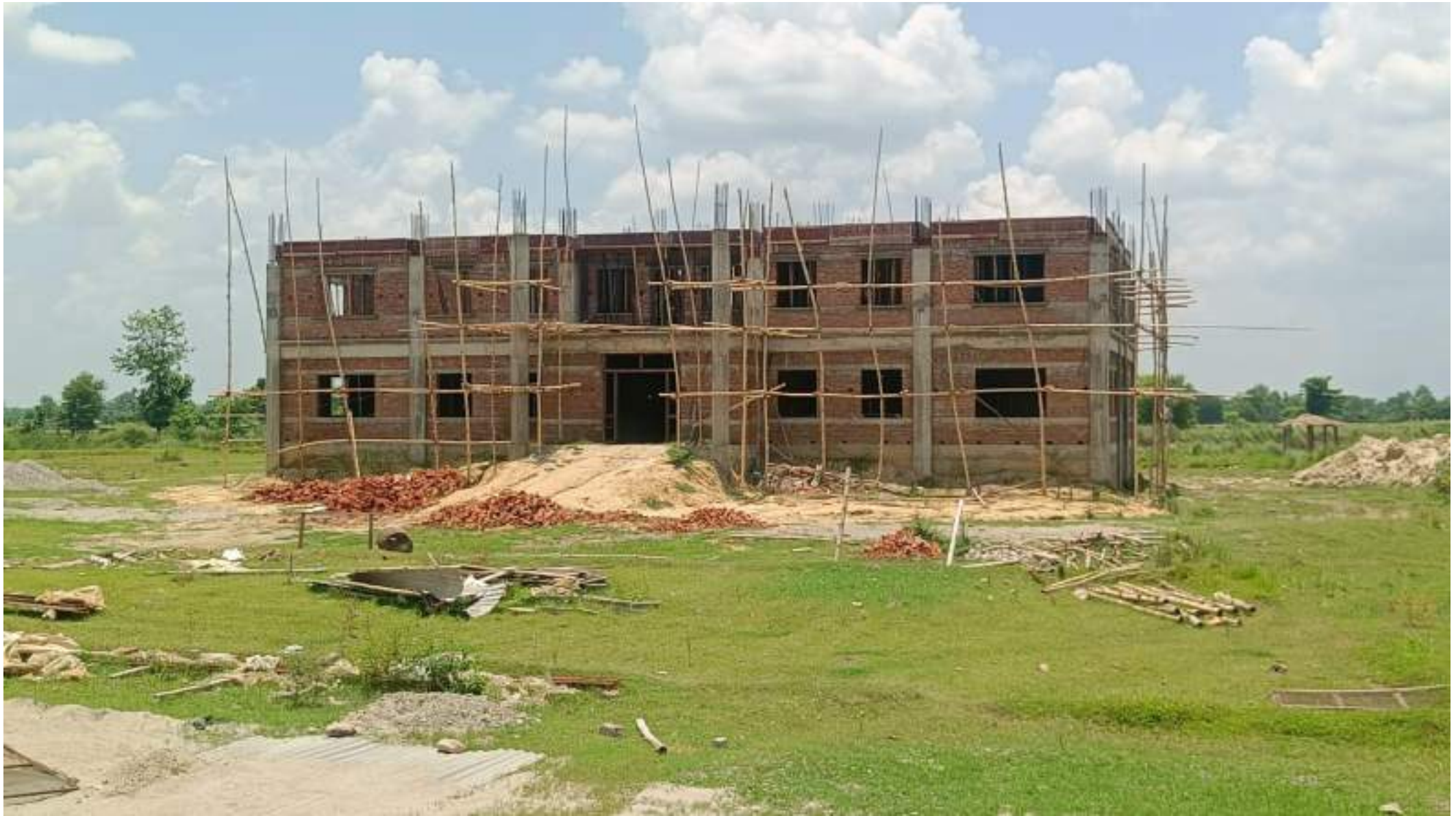
निर्माणाधिन गाउँपालिका प्रशासकीय भवन
