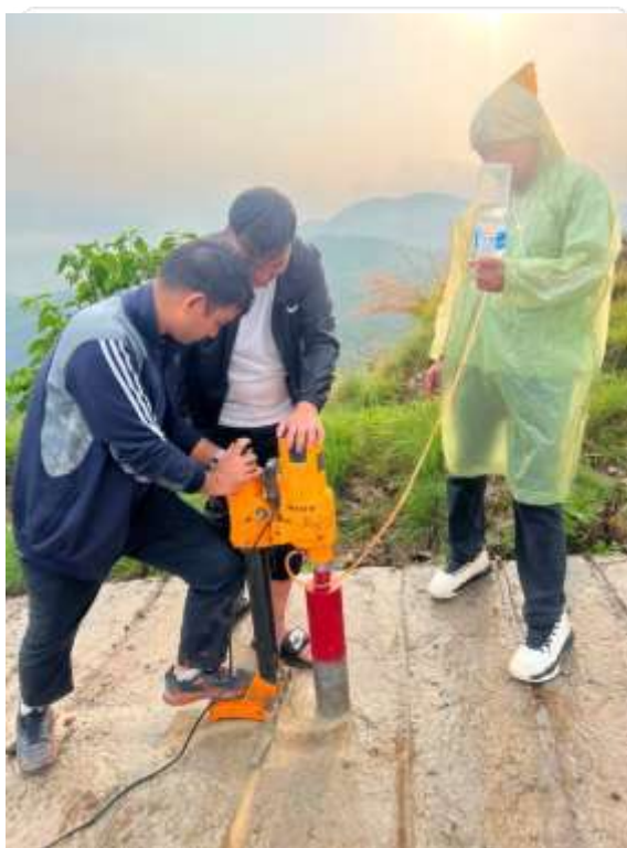
RCC मा Core cutting गर्दै
