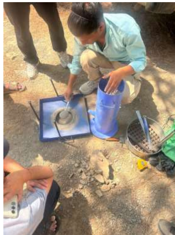
सडक निर्माण गुणस्तर परीक्षण
