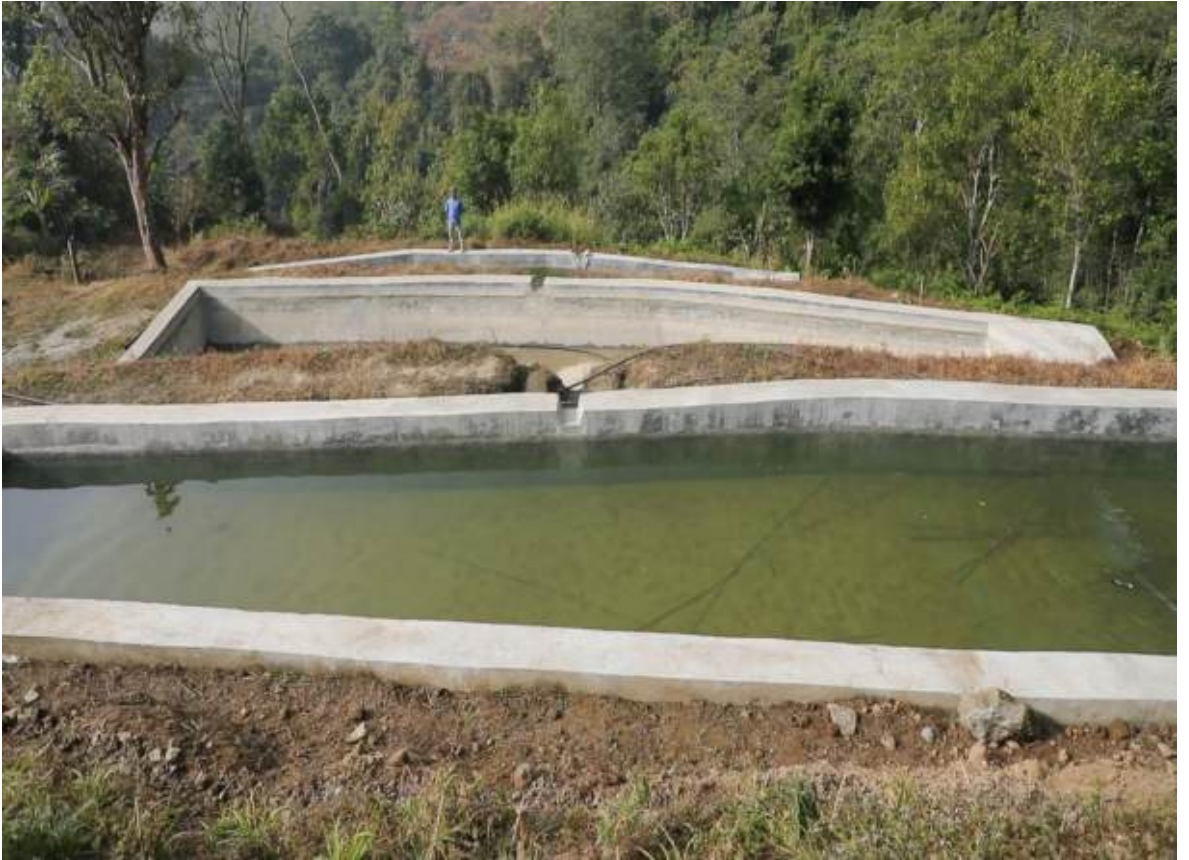
रेम्बो ट्राउन्ट माछा फार्म लेटाङ-७, मोरङ
