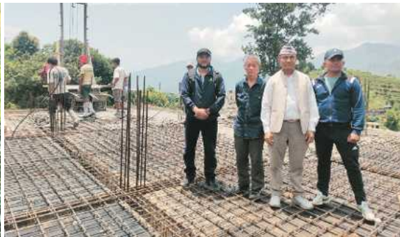
चिलाउने गुम्बा निर्माण योजना अनुगमन ।
