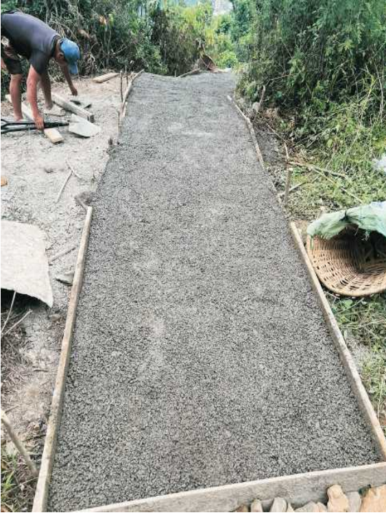
नौबिसे-सन्धासीटार-मगरगाउँ गोरेटो बाटो निर्माण वडा नं. ६
