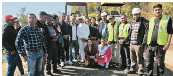
डाँडागाउँ कालोपत्रे सडक निर्माण योजना अन्तिम अनुगमन ।
