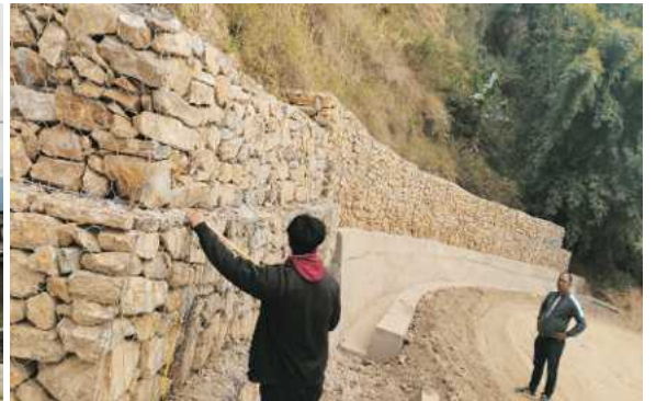
धारेखोला दर्शनढुङ्गे सडक ग्याविन वाल निर्माण वडा नं. ५
